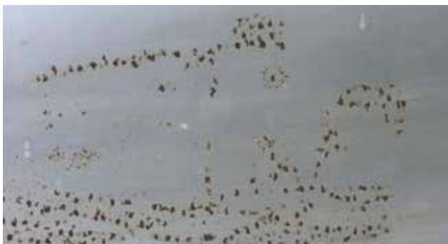
O cloro corrói o aço inox
